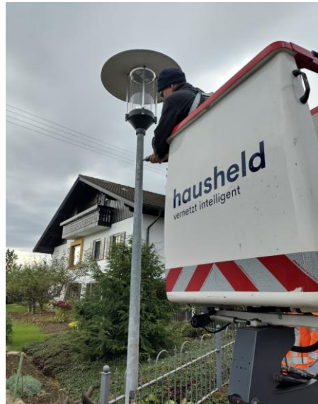
Kabeldurchführung wird gebohrt
