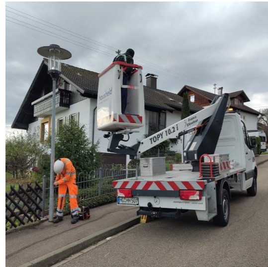
Stromversorgung wird angeklemmt
